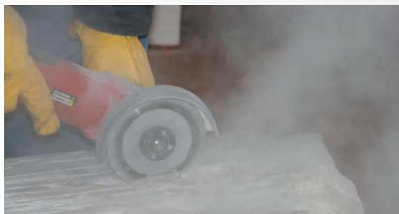
MINI AMOLADORA CORTANDO SIN CÁRTER DE ASPIRACIÓN
