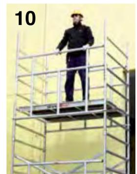
Cuando se sube a la plataforma, el módulo de protección ya está montado.
